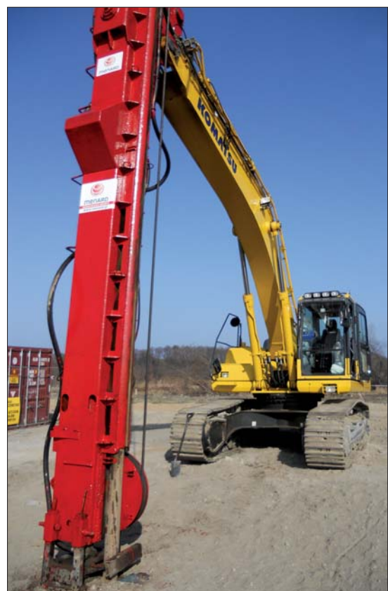
Fot. 1 Maszyna do wprowadzania ładunku materiału wybuchowego w podłoże gruntowe
