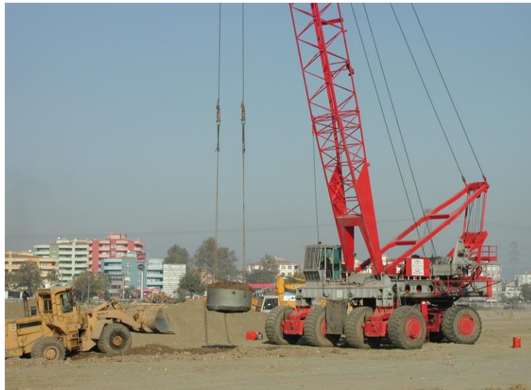
Rys.2. Żuraw kołowy o dużej nośności w trakcie dynamicznej wymiany
