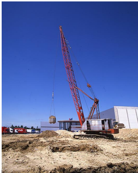
Rys.3. Wzmacnianie podłoża w pobliżu istniejącego budynku handlowego.
