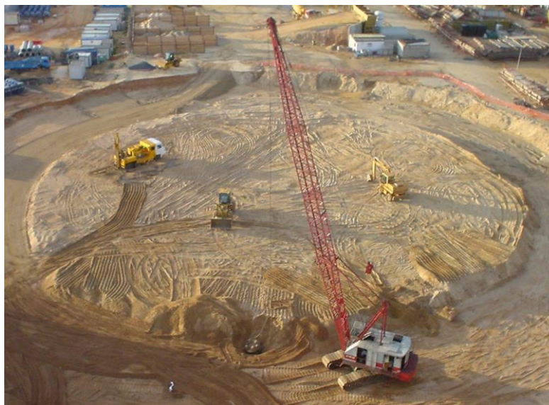
Rys.1. Wzmocnienie podłoża pod płytę zbiorników na gaz płynny.
