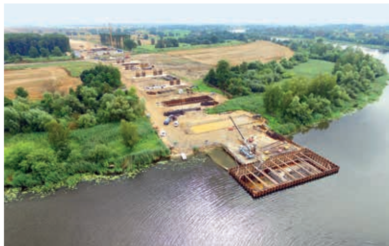
Obiekt MA-22 w km 48 + 302 do km 48 + 926 przez rzekę Nogat
