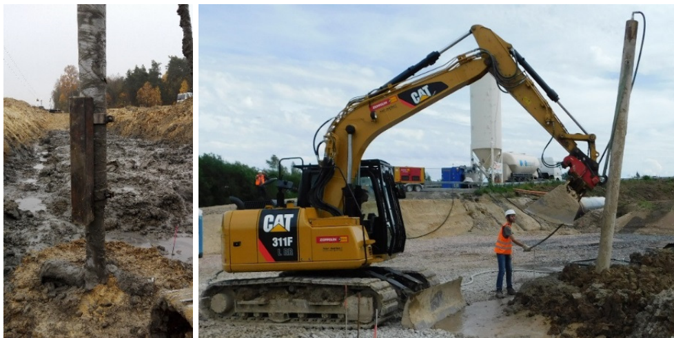
Rysunek 1. Próbniki do pobieranie cementogruntu z kolumn DSM
