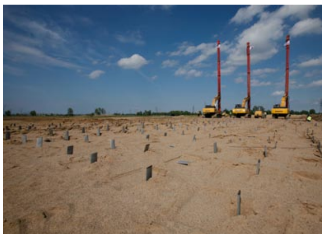
Rys. 5. Przykład zastosowania wzmocnienia podłoża w technologii drenów pionowych VD pod nasypem drogowym
