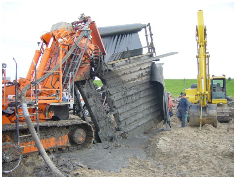
Figure 9 : Vacuum Taxiway – réalisation de l'écran étanche
