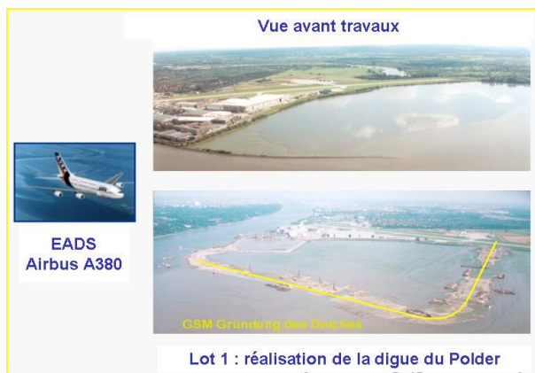
Figure 3 : Réalisation de la digue du Polder
