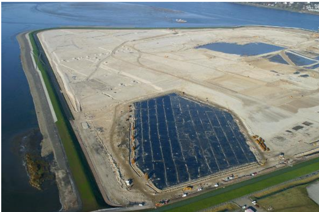
Figure 8 – Zone de dallage traitée par la technique du Menard Vacuum, bloc de 70 000 m 2
