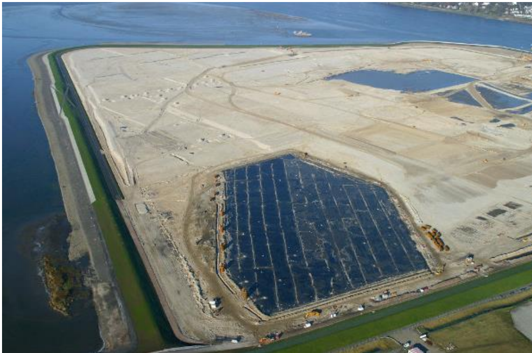
Figure 8 – Zone de dallage traitée par la technique du Menard Vacuum, bloc de 70 000 m 2
