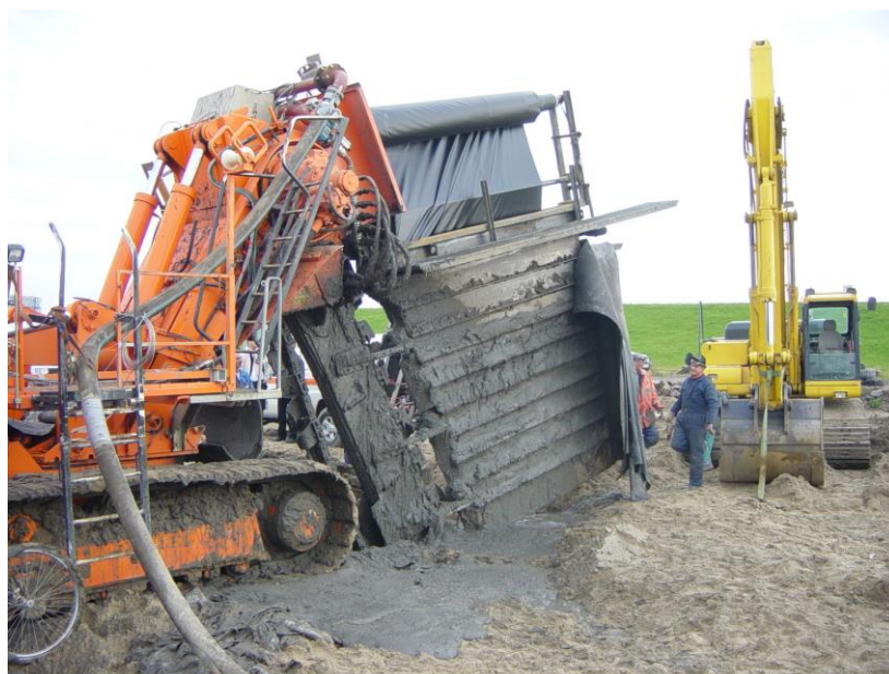
Figure 9 : Vacuum Taxiway – réalisation de l'écran étanche
