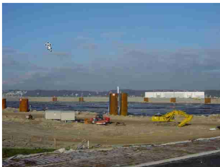
Figure 10 – Pose des virolles de protection des pompes eau-air
