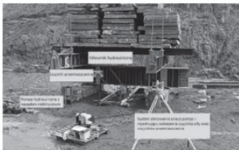
Rys. 1. Stanowisko pomiarowe do obciążenia statycznych metodą mieszaną (fot. archiwum Menard Polska Sp. z o.o.)
