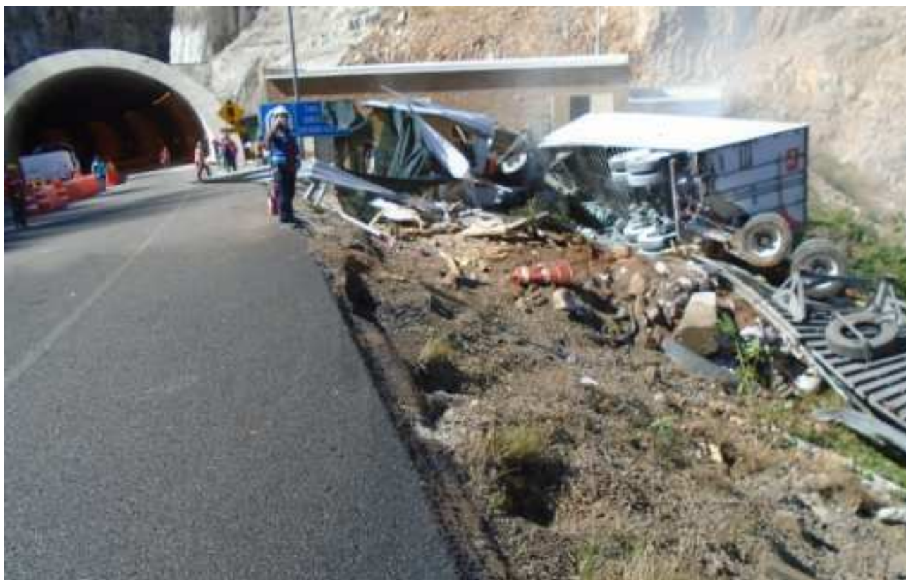
Ilustracja 2. Pojazd ciężarowy z dwoma przyczepami/naczepami zniszczył biuro położone tuż obok drogi: bariera została całkowicie rozerwana przez uderzenie
