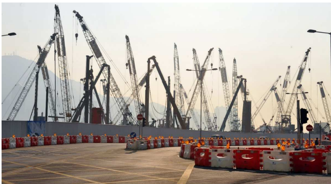
Ilustracja 7. Przykład objazdu z barierami plastikowymi i migającymi światłami
