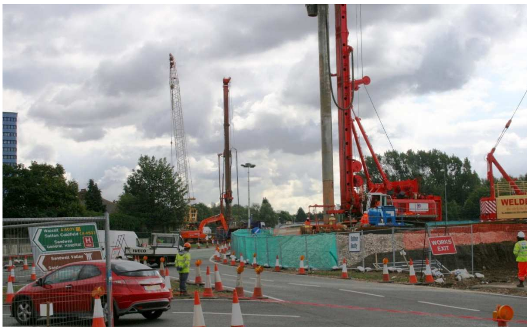
Ilustracja 6. Przykład odpowiedniego zarządzania ruchem w pobliżu miejsca pracy
