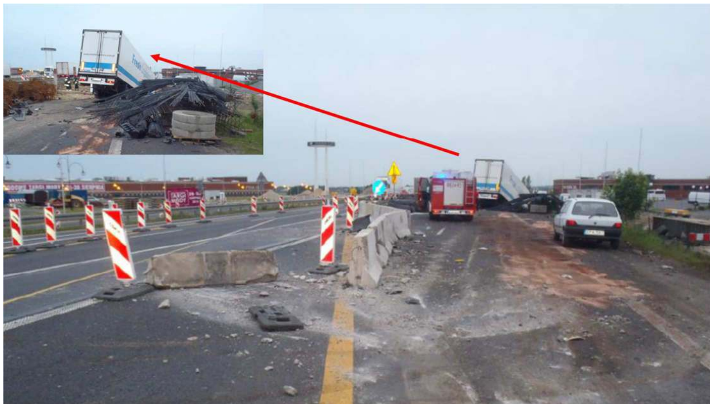
Ilustracja 3. Pojazd ciężarowy z dwoma przyczepami/naczepami zniszczył zaplecze przy autostradzie: betonowe bariery zostały rozerwane przez uderzenie i nie zatrzymały pojazdu
